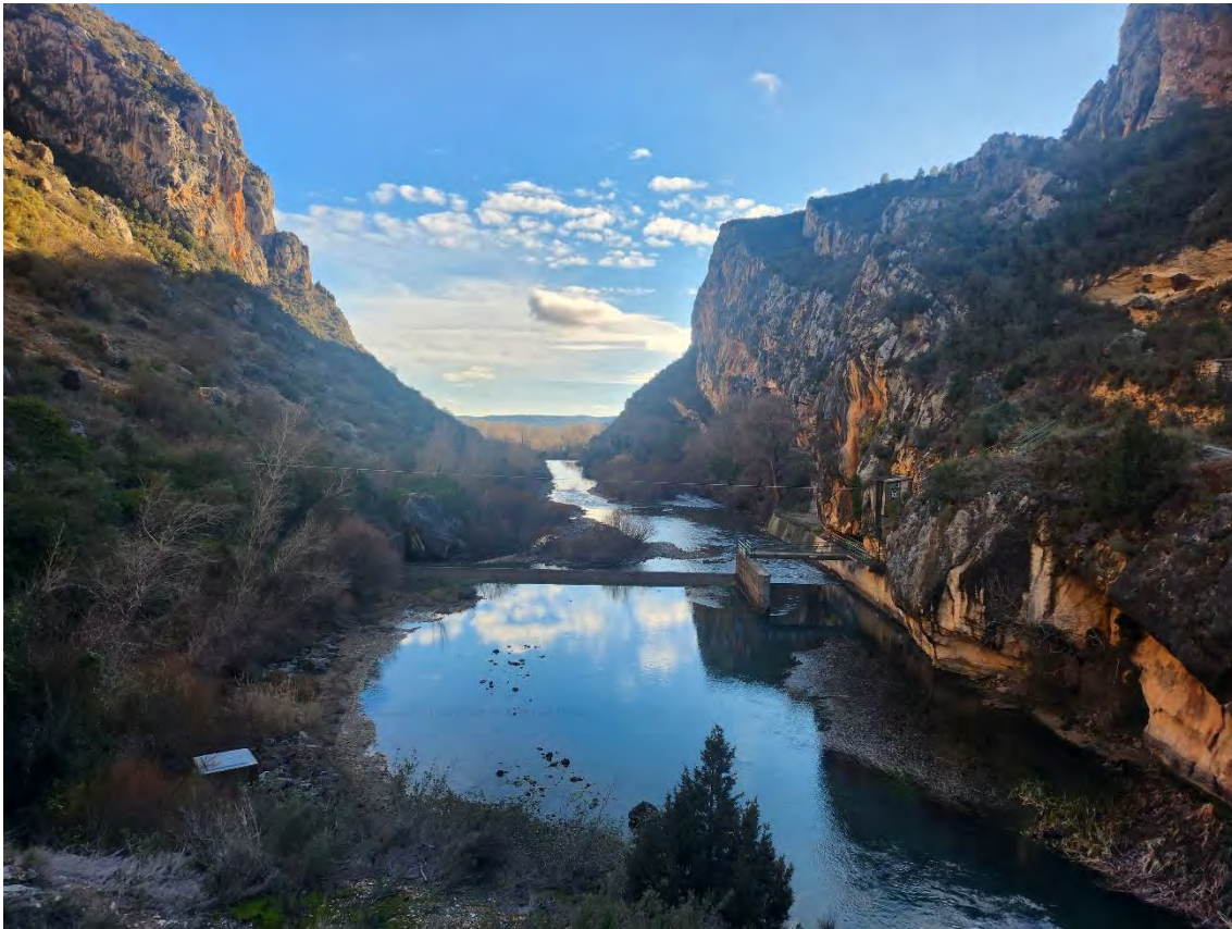
FIGURA 10. Estación de aforo A097 La Piñana. Se observa a la derecha el canal de aguas altas y el canal de aguas bajas por donde circula el agua. A la derecha podemos observar la caseta donde se halla instalado el limnógrafo: los mecanismos de medida del nivel de la lámina de agua, su almacenamiento y equipo de transmisión de datos.
