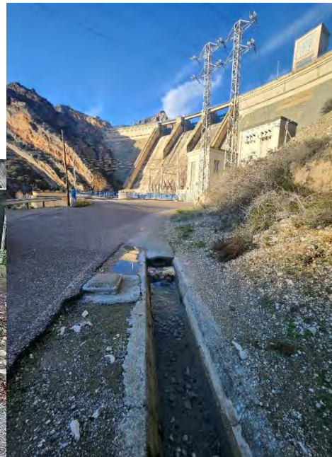
FIGURA 5. Fuente en la base de la presa.
