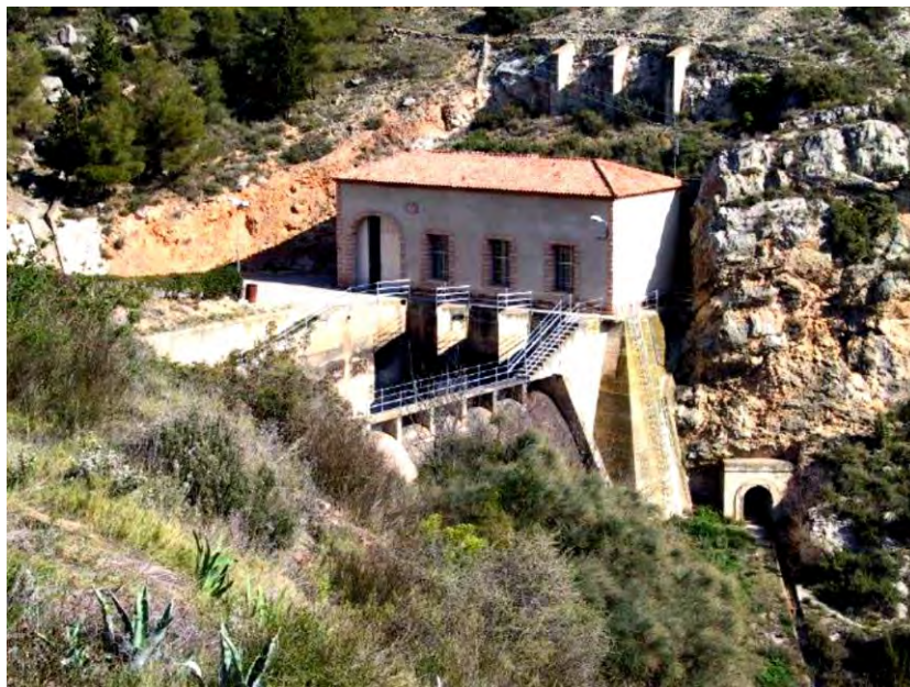
Figura 34. Vista caseta de compuertas del Canal de Enlace.
