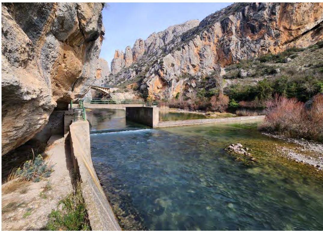
FIGURA 13. El canal de aguas bajas y el canal de aguas altas instalado en la estación de aforo.
