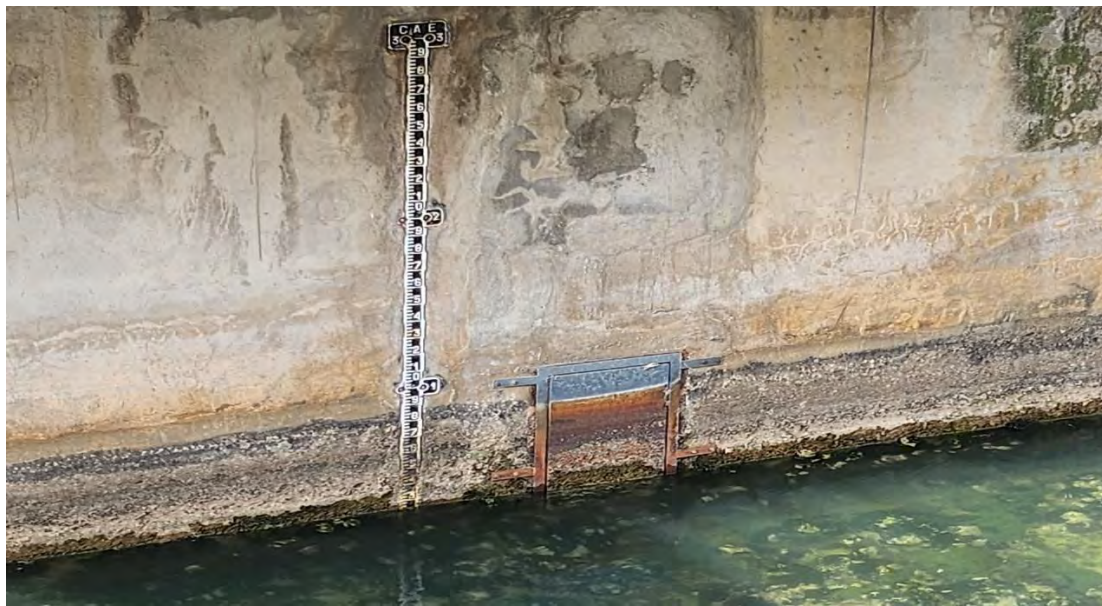
FIGURA 11. Estación de aforo a097 La Piñana. Escala limnimétrica y abertura entrada pozo lectura niveles.
