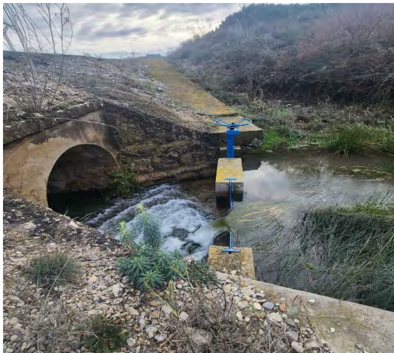
Figura 16. Vista detalle del vertedero triangular
