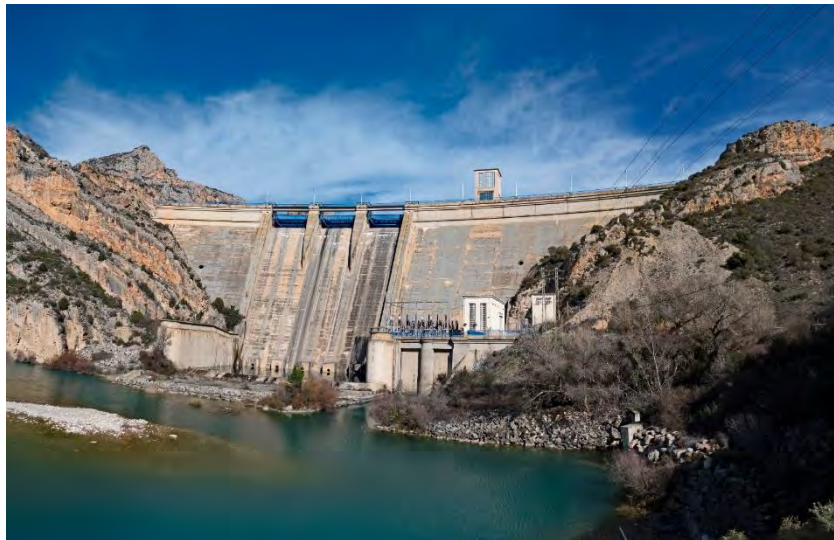
Figura 30. Vista general de la presa y central hidroeléctrica de Santa Ana
