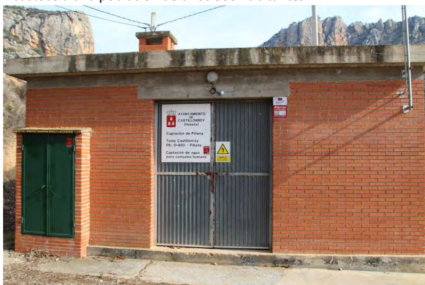
Figura 41. Estación de bombeo para agua de boca de Castellonroy
