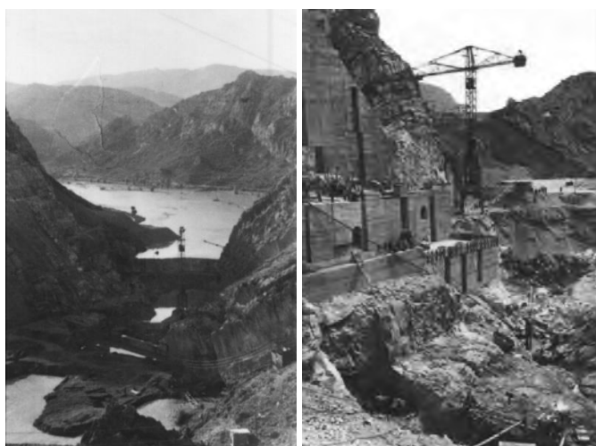
FIGURA 22. Imágenes históricas de la presa de Santa Ana año 1955 y 1956. Fuente: (CHE)
