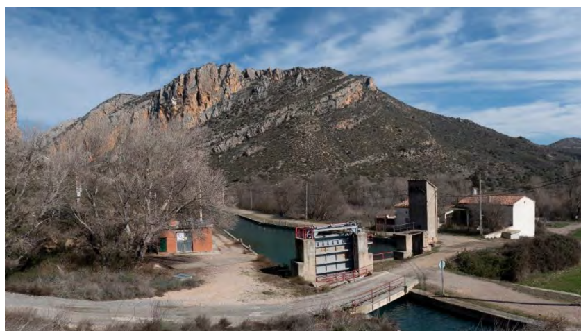
Figura 40. Vista de la estación de bombeo de Castellonroy, compuerta del Canal de Piñana, compuerta del agua de boca a Lleida y demás poblaciones de la ribera. Al fondo la sierra de Monderes.
