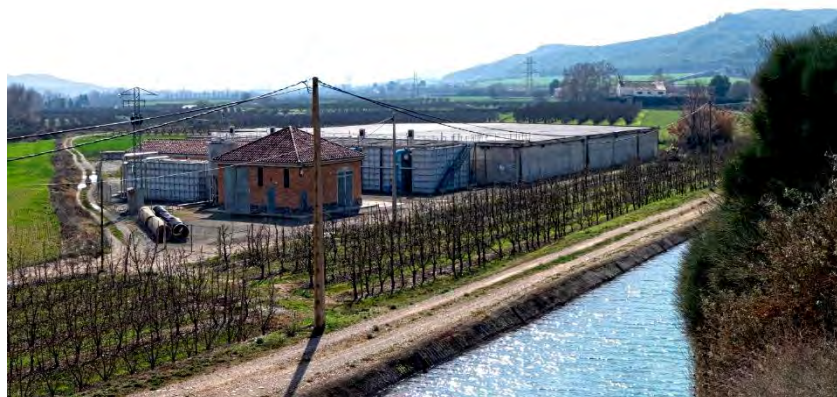
Figura 42. Planta potabilizadora para abastecimiento de agua de boca para Lleida y demás poblaciones de la ribera del Noguera Ribagorzana.
