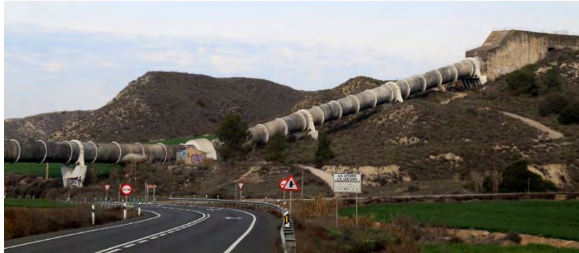
Figura 37. Sifón de Castillonroy, obra singular del Canal de Enlace sobre la N-230.
