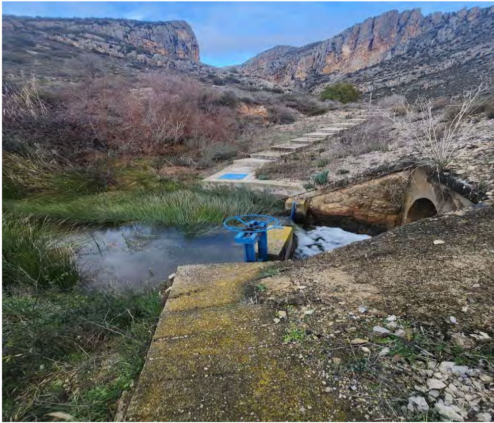
FIGURA 17. En el margen izquierdo observamos la arqueta de acceso al pozo de medida medida del nivel de la lámina de agua.
