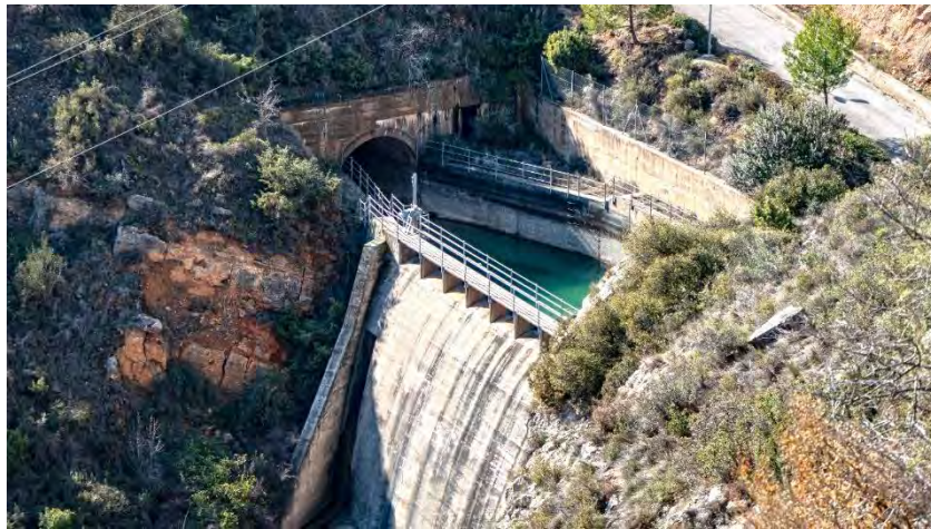
Figura 35. Canal de descarga del aliviadero y compuerta del Canal de Enlace.
