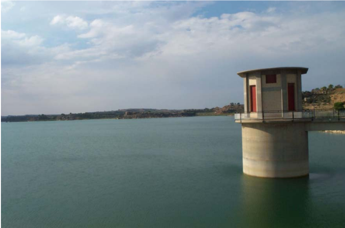
Panorámica del embalse desde la presa. Torre de toma de agua
