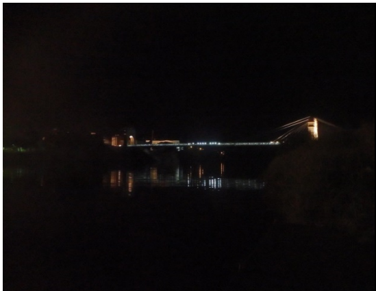
Figura 62: Vista del Puente de Amposta desde el embarcadero.
