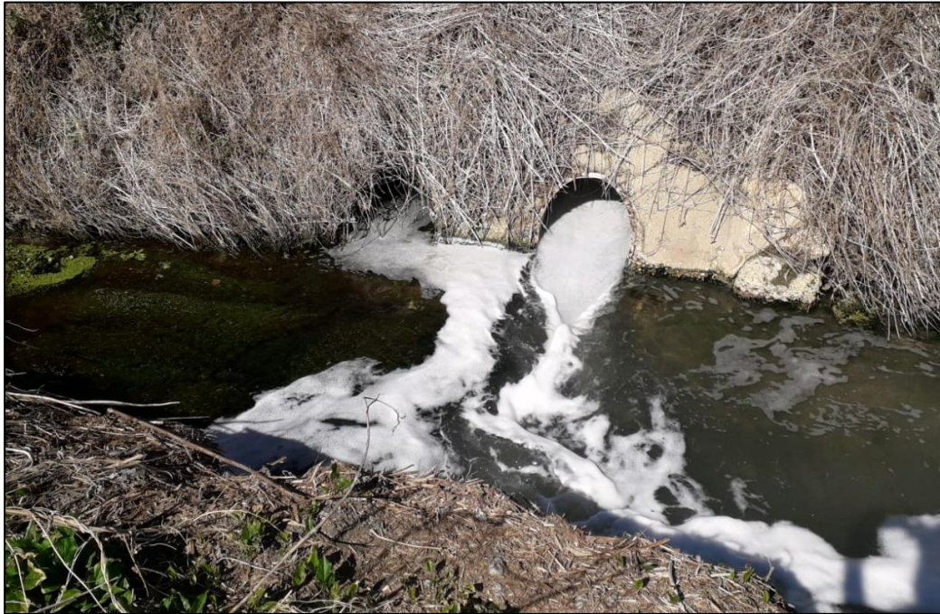
Vertido EDAR Ágreda-Ólvega en río Val (cuenca del Queiles) (11/3/2019).
