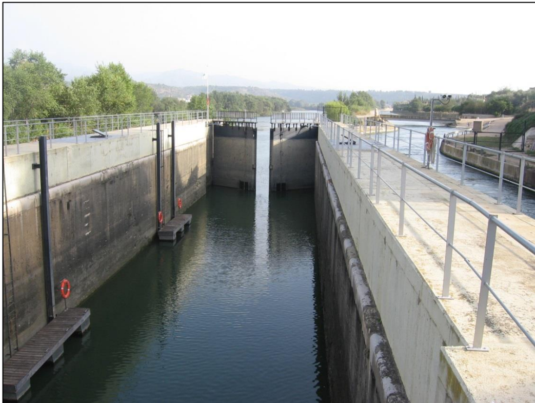
Canal margen derecha del Ebro (15/10/2008)
