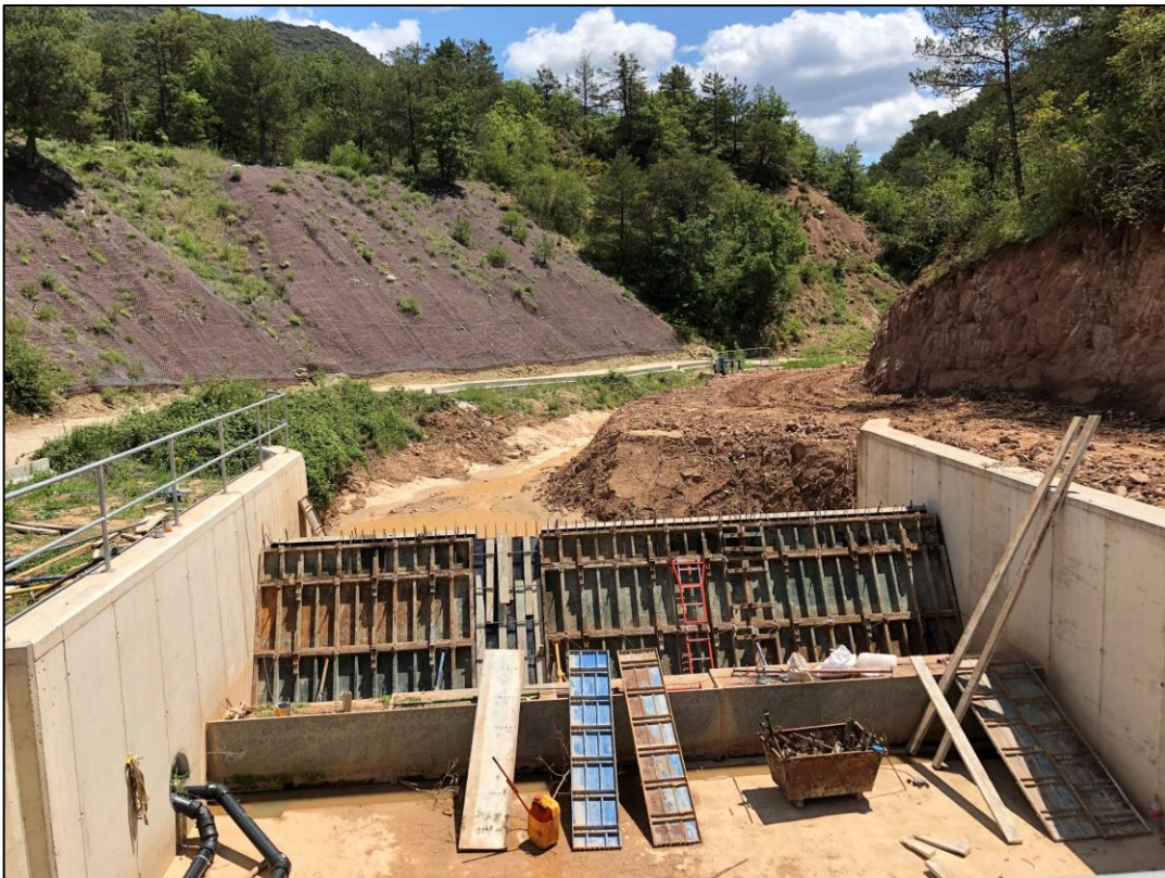
By-pass en el barranco de Bailín (Sabiñánigo) (19/6/2019)
