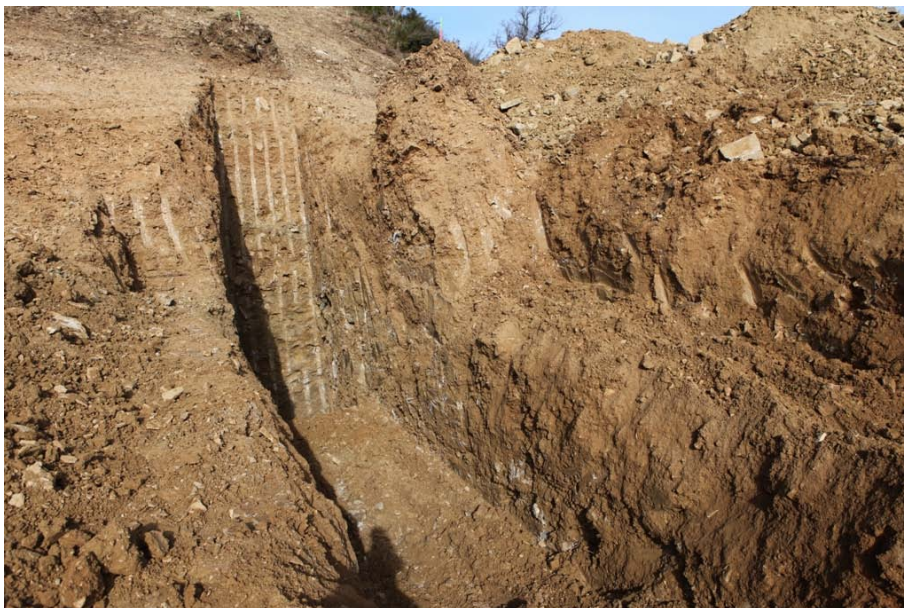
Figura 12. Trincheras de reconocimiento excavada junto al punto 10 en la que se expuso un depósito de deslizamiento de al menos 6 m de espesor formado por una brecha de flysch. En el
