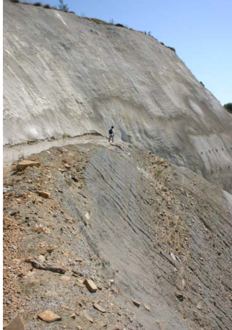
Figura 5. Zona de excavación del estribo derecho de la nueva presa, en la que afloran margas y flysch buzando hacia el interior de la ladera. Imagen tomada en agosto de 2007.
