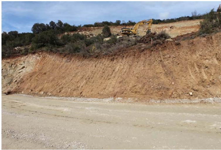
Figura 8. Punto de observación 4. Surco longitudinal parcialmente relleno de facies coluviales con matriz marrón anaranjada. Al oeste el flysch se encuentra brechificado, mientras que al este (ver figura 9) presenta un buzamiento general hacia el valle y fracturas dilatadas rellenas de margas y cantos de arenisca.
