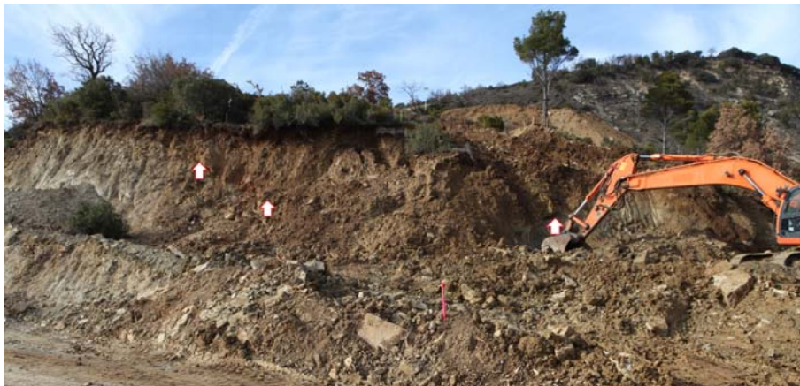
Figura 14. Vaguada longitudinal atribuida a límite este del deslizamiento. Al oeste de la misma (izquierda), flysch brechificado.
