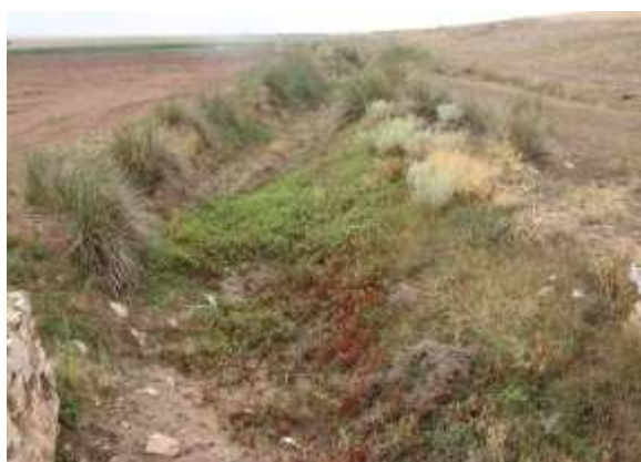
Canal del Jiloca aguas arriba de Monreal.
