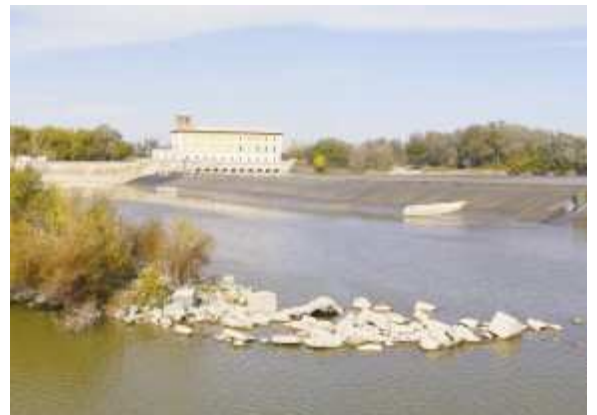
Casa de compuertas del Canal Imperial de Aragón.
