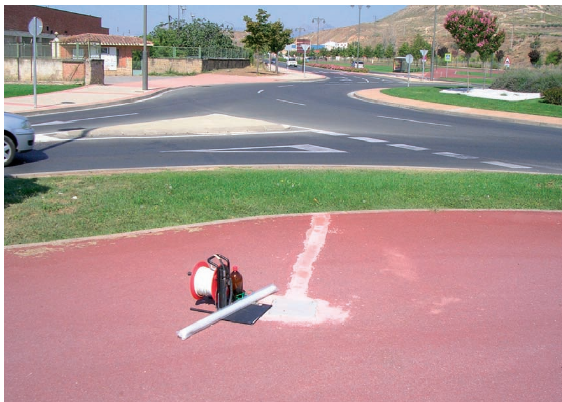
■ FIGURA 5.3.26 PIEZÓMETRO 231010144 LOCALIZADO EN EL FOCO DE CONTAMINACIÓN. (04/09/2013). ZONA 048-02
