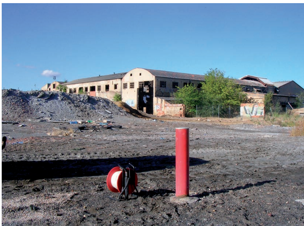
■ FIGURA 5.3.41 PIEZÓMETRO 281510255 LOCALIZADO EN EL ENTORNO DE LA ANTIGUA EMPRESA QUÍMICA (16/10/2013). ZONA 058-04
