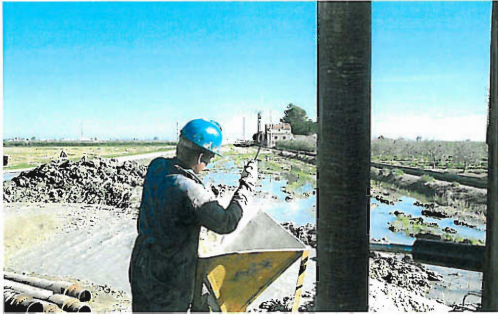
Mezclando bentonita.
