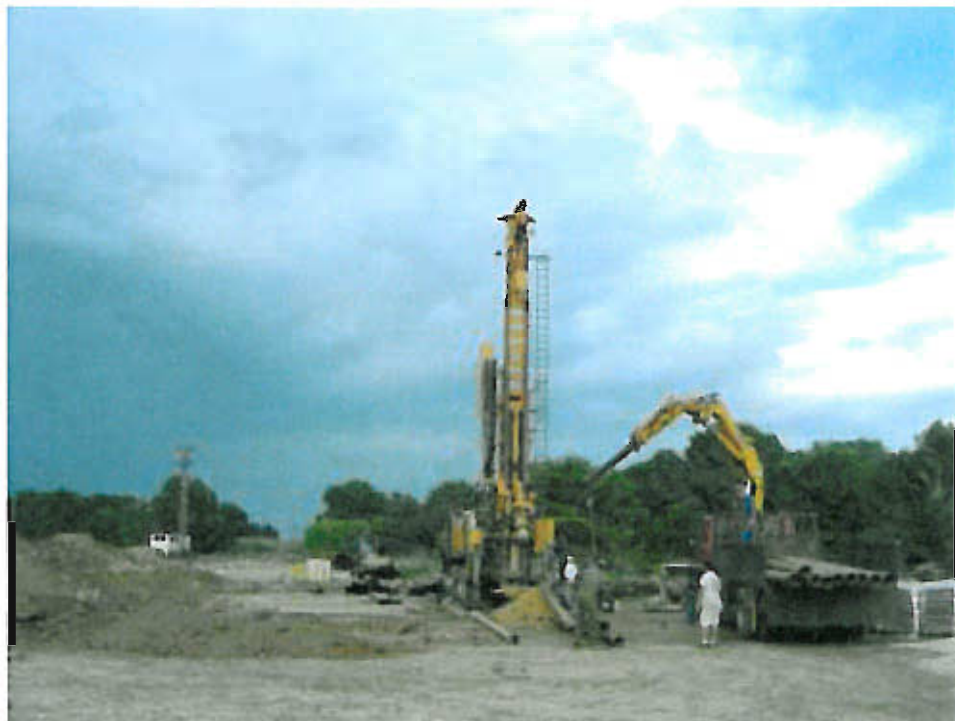
Emboquillando en Camarles (18-10-2006)
