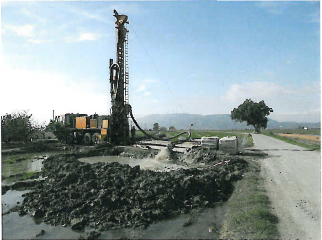
Vista de la sonda de perforación y de la balsa de fangos.
