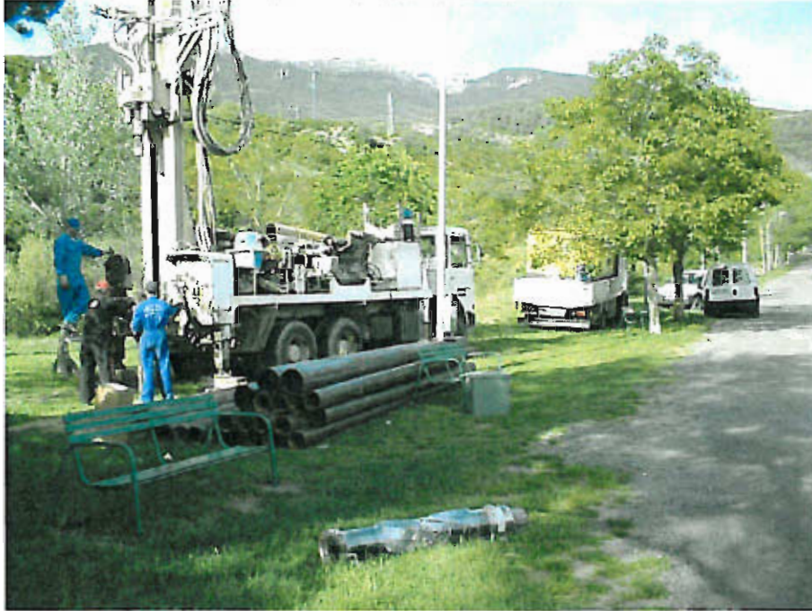
Sonda ubicada en emplazamiento previsto.
