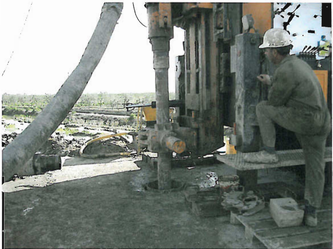
Detalle de perforación sobre la plataforma de hormigón construida.
