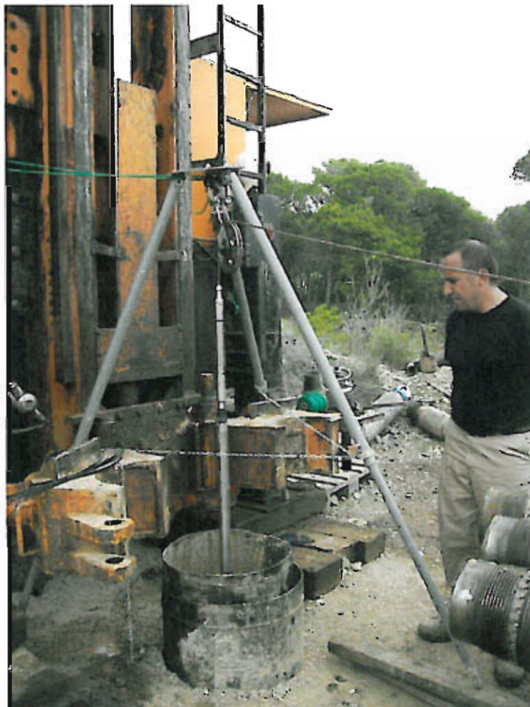
Detalle de la primera sonda preparada para su introducción en la perforación.
