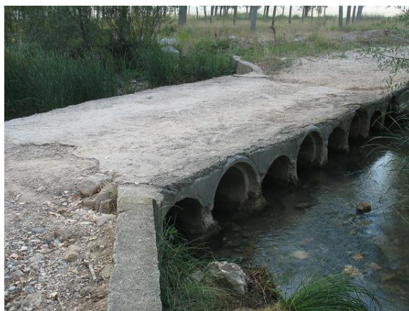
Figura 12-12. Vado en el tramo bajo río Homino.
