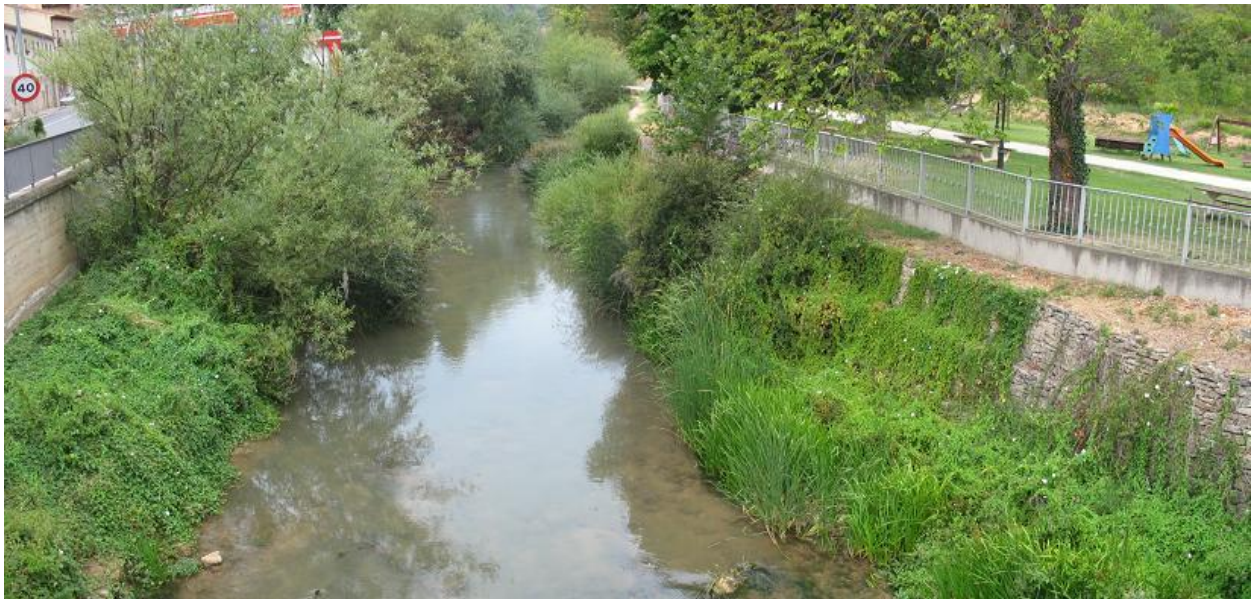
Figura 12-8. Canalización del río Oca en la localidad de Oña.
