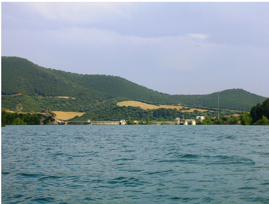
Figura 7. Vista de la presa del embalse
