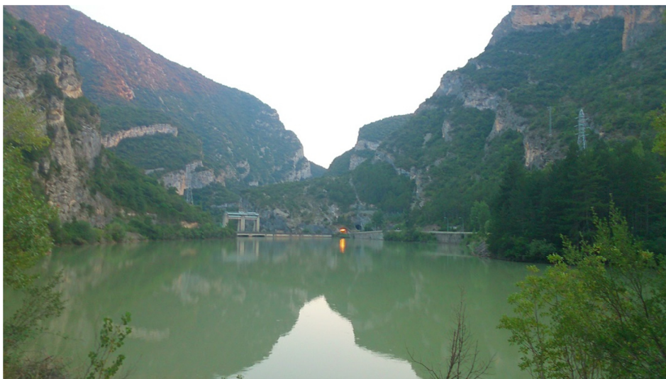
Figura 7. Vista de la presa del embalse
