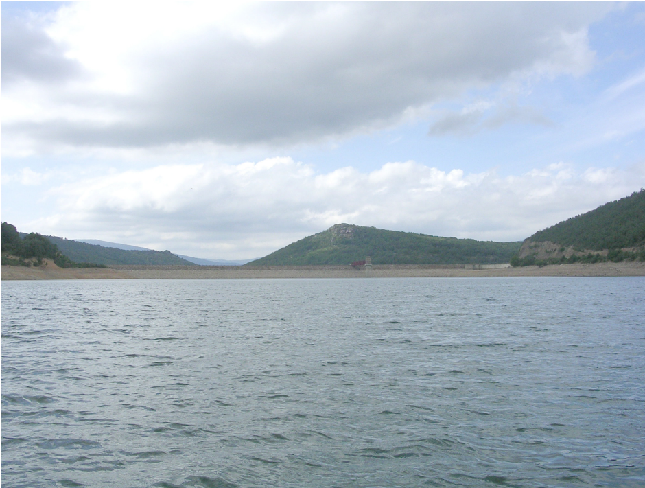
Figura 7. Vista de la presa del embalse
