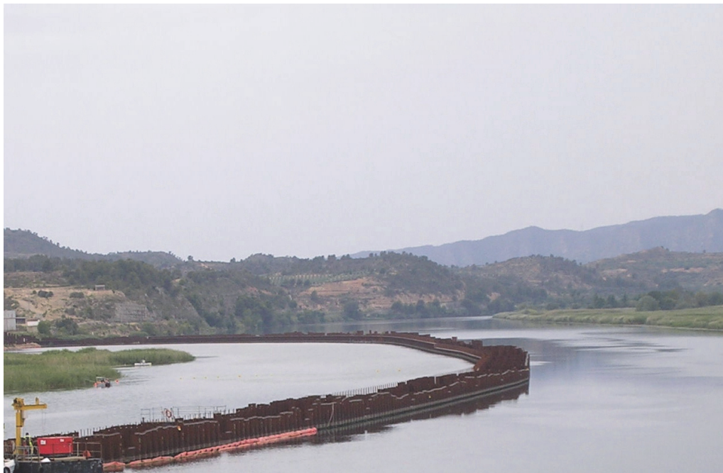
Figura 7: Vista del embalse y la zona de obras
