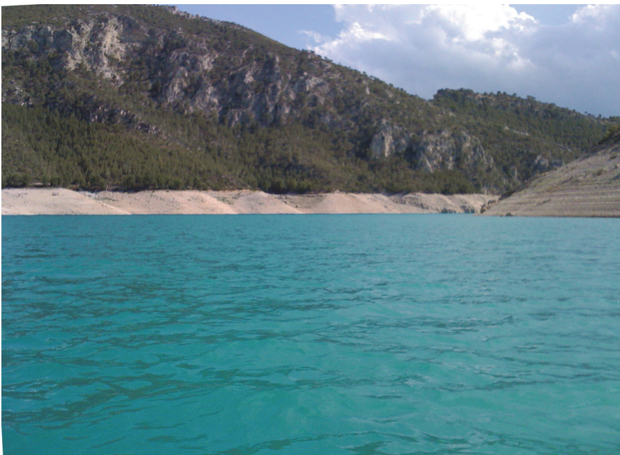
Figura 8: Vista de la cola del embalse de Calanda
