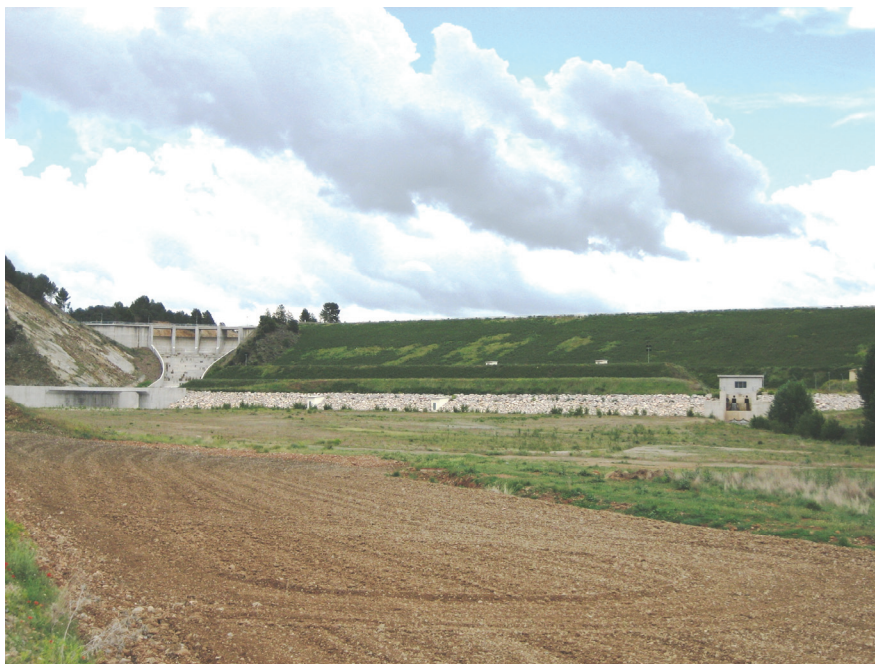
Foto 1: Presa del embalse
