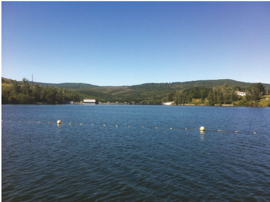
Figura 7. Vista de la presa del embalse
