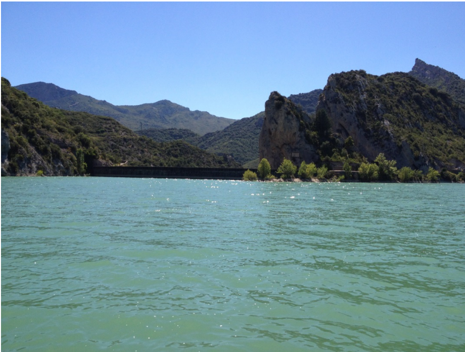
Figura 7. Vista de la presa del embalse
