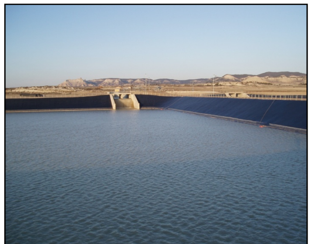
Detalle de la entrada de agua a la balsa de Sora
